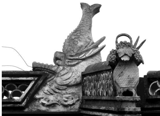
周庄 古い建物の大棟を飾る瓦
