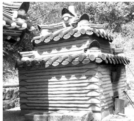
驪州 神勒寺 遺物焼却炉
